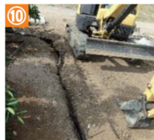
⑩ 掘削土を溝に戻す。
