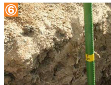
⑥ S.シートの埋設深である50cmを確認しつつ進める。
