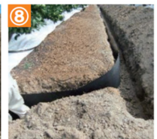
⑧ S.シートの埋設。 ※シートの継ぎ足しは50cm程度重ねる。
