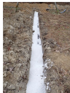
写真8 暗渠施工後に多孔質資材(この例ではハイドロボール)で埋め戻した園地
