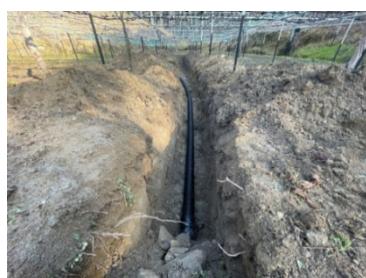
写真7 暗渠施工した「シャインマスカット」園地
