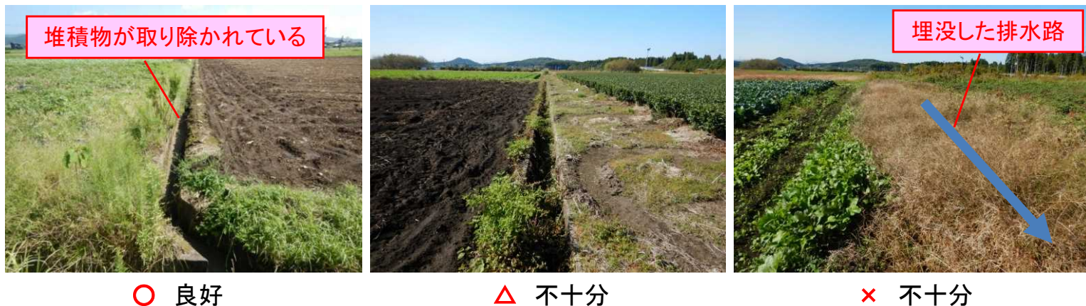
図52 支線排水路の管理状況
