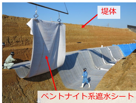
(b) ベントナイト系遮水シート敷設状況
