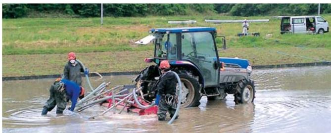
写真2 / 水による土壌攪拌・除去方式の除染
