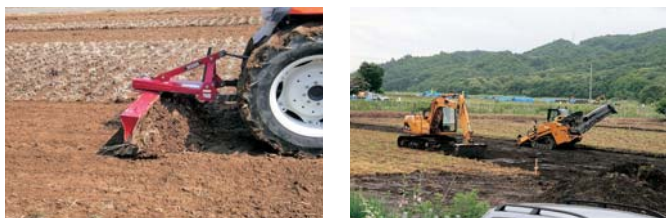
写真1 / 農業機械や建設機械での表土除去による除染
