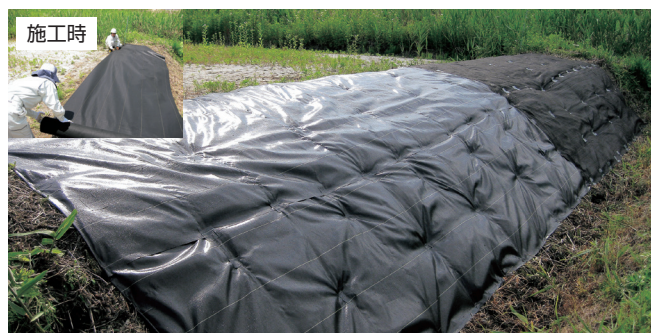
写真3 / 防草シートを施工した法面
