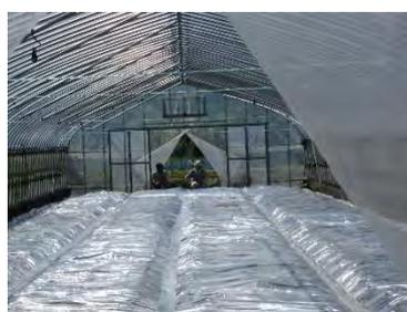
図3-7 被覆し、水を入れたポリチューブで押さえています
