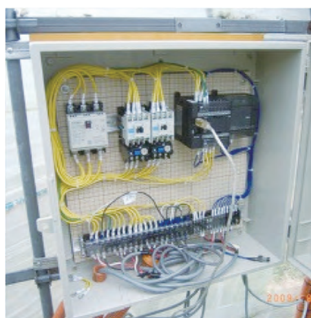
図 15 噴霧コントローラ内部の構成と構成部品のパーツリスト
