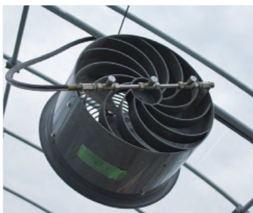
図4 採用した細霧ノズル付循環扇 (F社 MHC-2100)
