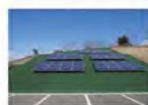
総合運動公園への太陽光導入
