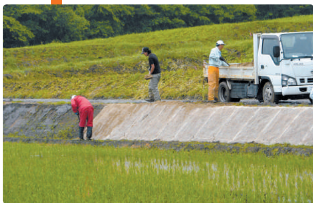
二重ネットの展開と目土入れ
