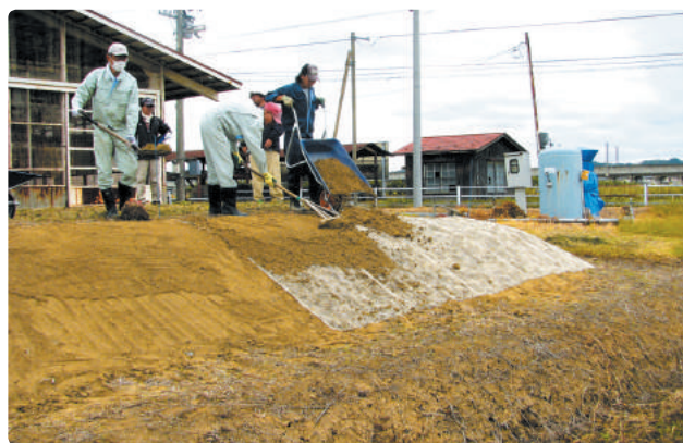
二重ネットの展開と目土入れ
