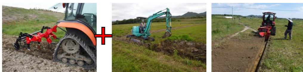
図1-2 水田の放牧向け草地の造成に必要な排水対策
