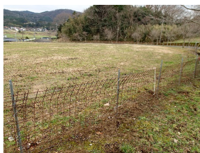
ワイヤーマッシュ柵の設置で掘り起こし被害防止
