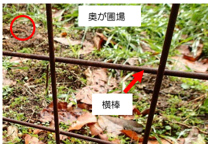
圃場側に横棒がくるように設置する
