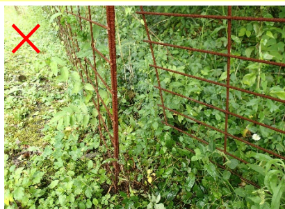
合わせ目の重ねなかったため 侵入された
