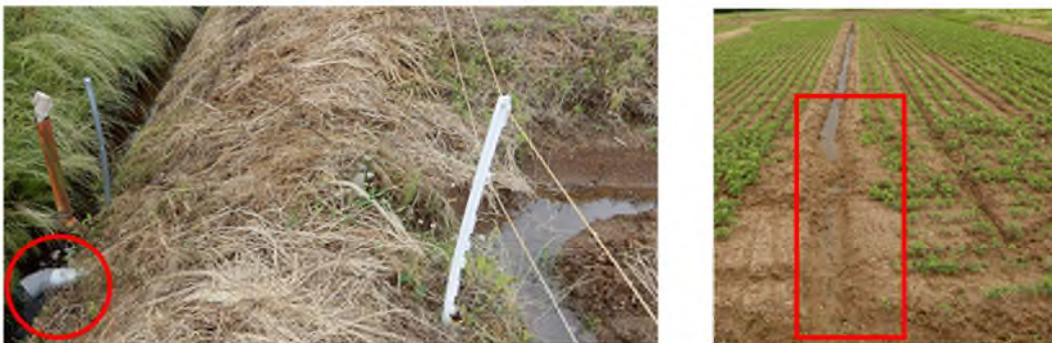
図3-5 出雲市地圃場の額縁明渠と落水口の接続不良と(左)と圃場内部の明渠と額縁明渠の接続不良(右)
