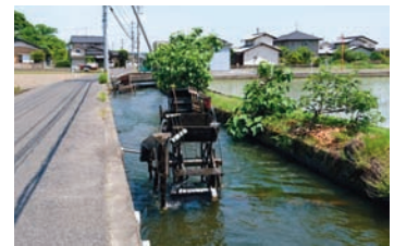
写真 祐安地区の揚水水車
