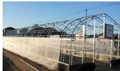
アーチパイプの間隔は1.5mとした
