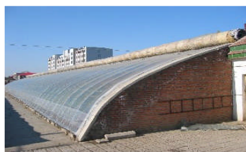
日光温室の外観。東側に見える壁はレンガ作り。外面被覆は「わらごも」のように断熱性が高い。
