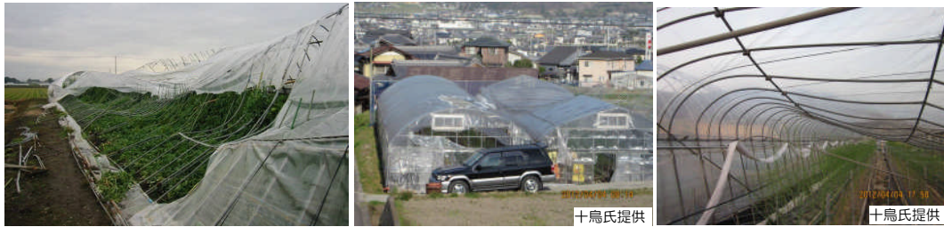
図5 強風により被災したパイプハウス
