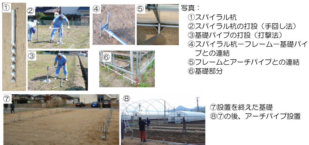
図 15 スパイラル杭を用いたフレーム工法による基礎の補強
