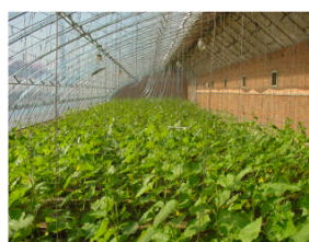
日光温室の内部。右側はレンガ造りの北壁。断熱と蓄熱の機能を持つ。
