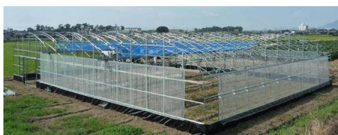
ダブルアーチ構造の3連棟パイプハウス
