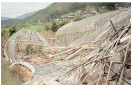
写真 被災したパイプハウス
