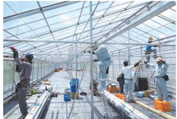
写真1 陸前高田市の実証用パイプハウス建設の様子
