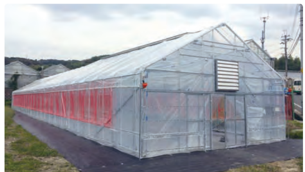
写真2 奈良県の業者が施工した新設計のハウス
