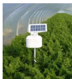
▲図3 遠隔測定システムの設置状況
