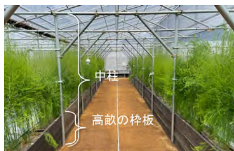
▲写真2 中柱（補強）を活用した高畝の桝板抑え構造
