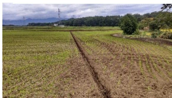
図11 明渠の施工状況(2024.10)
