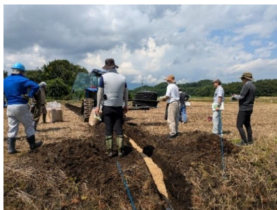
図12 暗渠の施工状況(2024.8)
