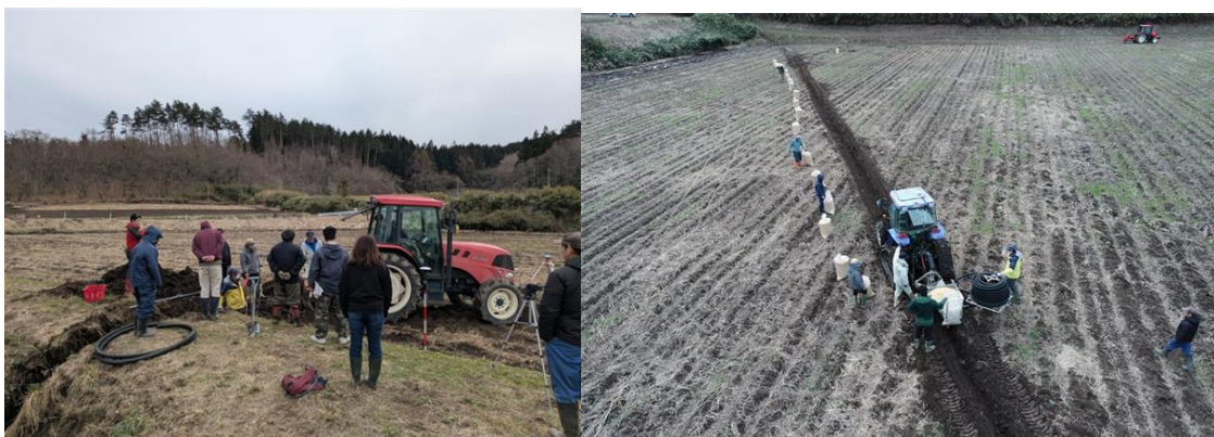
図5 暗渠の施工状況(2025.4.1)
