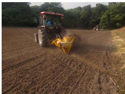
図4 明渠の施工状況(2025.6.20)
