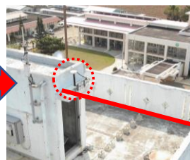
可搬式基地局を固定基地局として設置・利用
