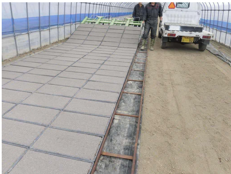
散水シャトル用レールを敷きながらの定置作業
