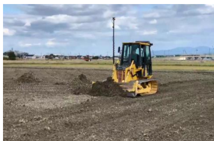
図2 農業ブルドーザによるICT均平施工
