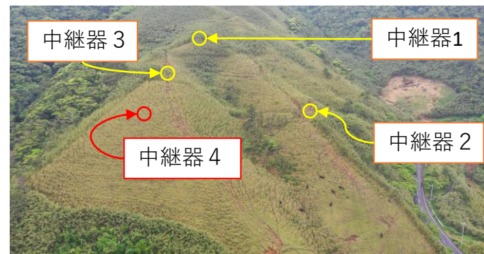
中継器の設置
