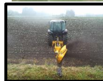
溝堀機による明渠施工
