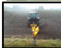
溝堀機による明渠施工
