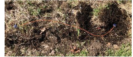
写真3 エリヤワイヤの切断箇所（修繕後）
