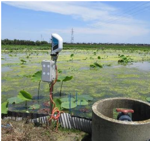
水位センサーの 設置状況
