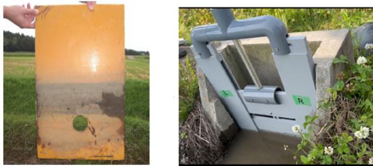
図12 従来の落水量調整板(左)とスマート排水制御機器(右)
