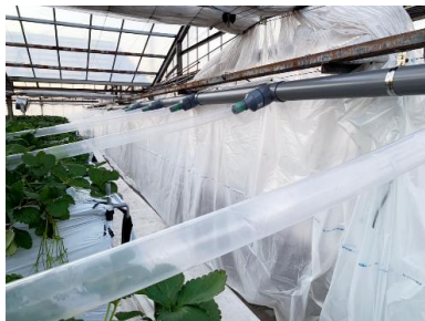
図6. ヒートポンプからの配管の様子
