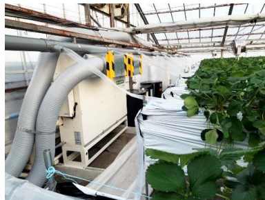
図6. ヒートポンプからの配管の様子
